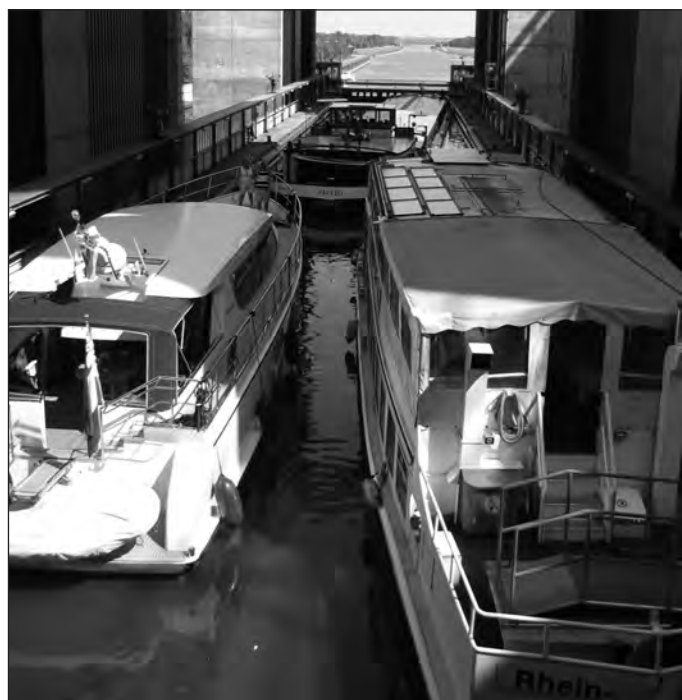
Im Schiffshebewerk wird viel Schweres bewegt...
